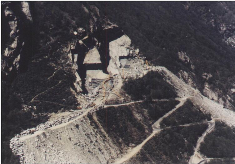
Figura 40: precedenti recuperi ambientali di discariche di cava (1980/90) con impiego di fanghi di segagione miscelati a clasti più grossolani e frazione organica.
