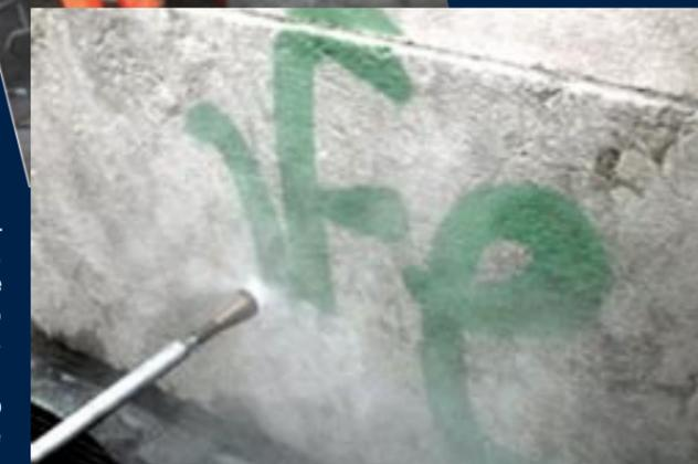
grado di rimuovere ogni deposito o impurità quando impattano a distanza ravvicinata una qualsiasi superficie. Più specificatamente, la tecnologia di supporto degli utensili Airmation ultra-rotanti impiegati (Airmation serie FINE-JETS manuali o automatici) fraziona la forza pulente in una pluralità di microgetti ad alta energia cinetica e massa esigua.
