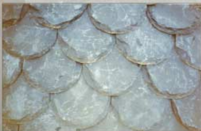
Particolare di copertura a squame tipo svizzera
