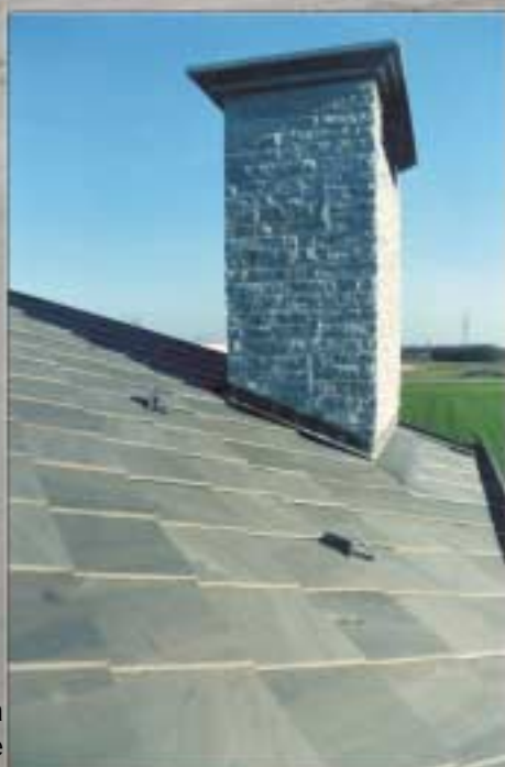
Particolare di copertura tipo francese
