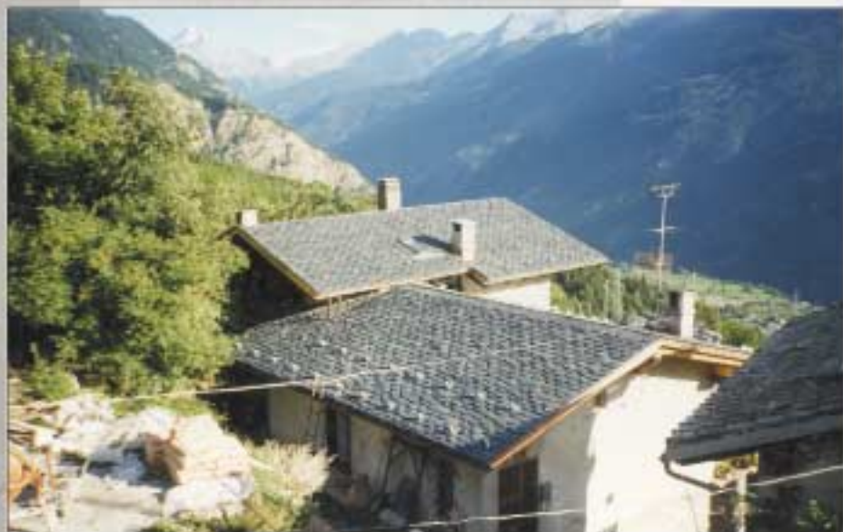
Copertura tipo bergamasca
