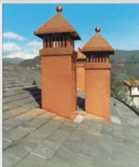
Copertura alla francese
