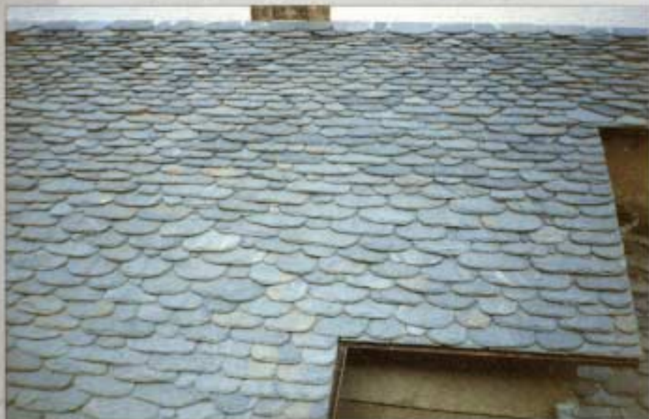
Tetto con copertura tipo rustica
