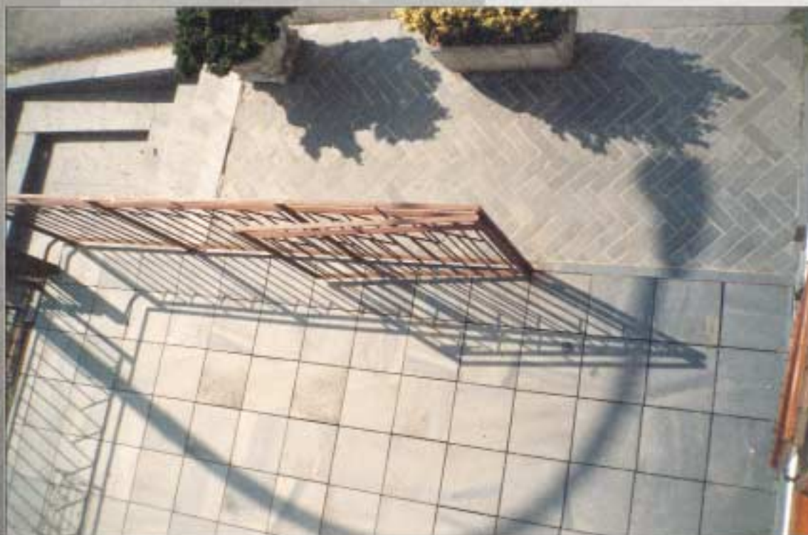
Pavimentazione a lastre quadrate e rettangolari
