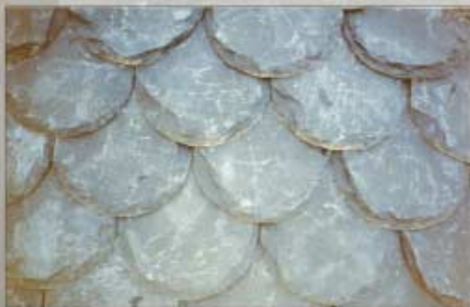
Particolare di copertura a squame tipo svizzera
