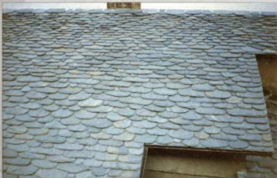
Tetto con copertura tipo rustica
