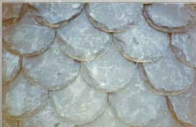
Particolare di copertura a squame tipo svizzera
