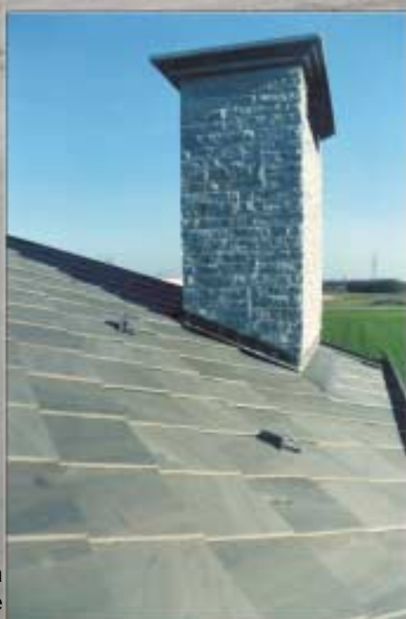
Particolare di copertura tipo francese
