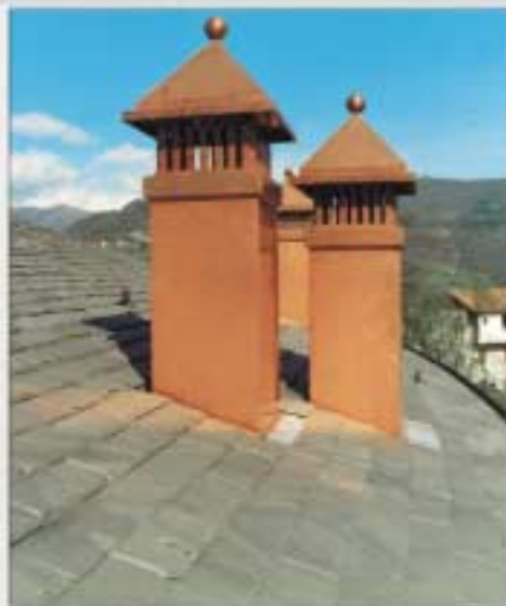
Copertura alla francese
