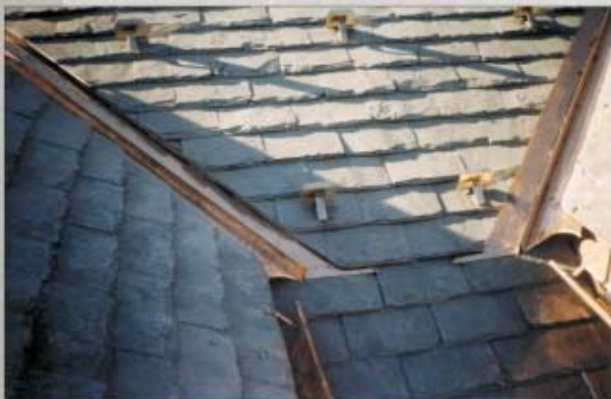
Copertura alla francese con fermaneve
