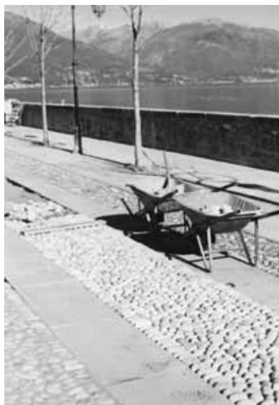
Per le zone delle piazze IV Novembre e Marinai d'Italia (oggetto di un successivo stralcio di lavori) si è sostituito l'asfalto con un lastricato con cubetti di porfido e granito l'inserimento di alberature attuando così, attraverso disegni e colori delle superfici, un collegamento ideale con le aree pedonali del Municipio nell'antistante piazza Dante.
